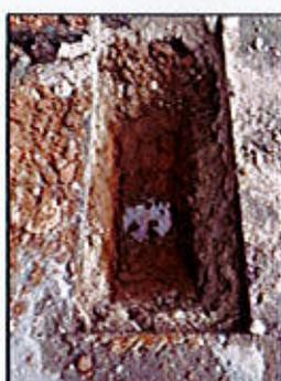
*Photos n°2 et n°3 : Venues d'eau dans la fouille F1 à l'ouverture et après 5 minutes.*
